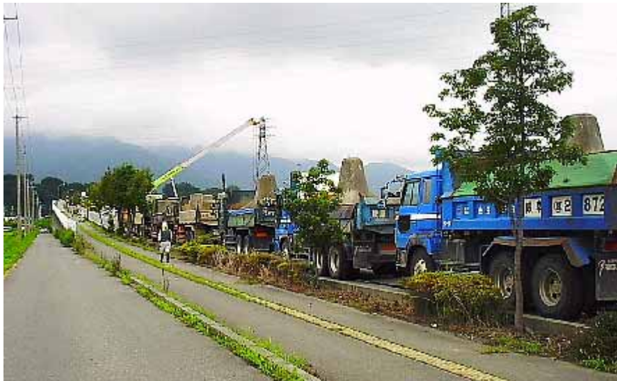
図5 堤防補強用のテトラを積載しているトラック群
