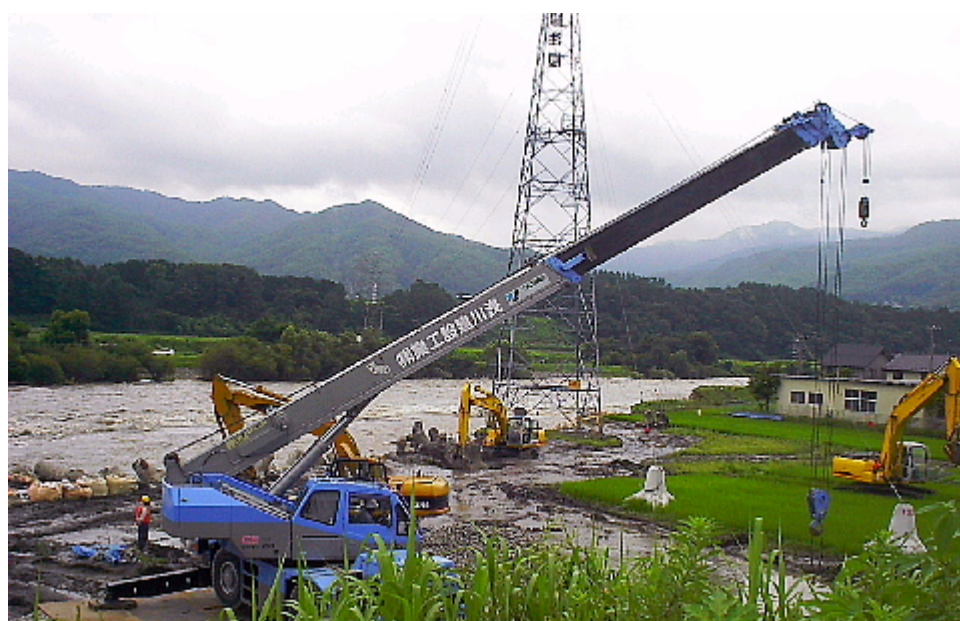
図3 堤防決壊場所の補強工事（鉄塔は幹線用の高圧鉄塔）
