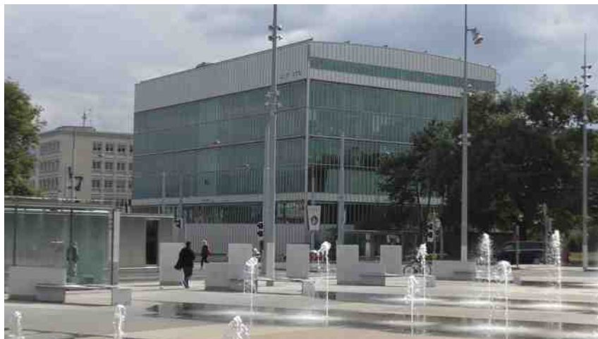
会議が行われた Montblanc ITU ビル
